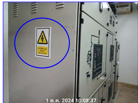
รูปที่ 2.22 ตู้ควบคุมไฟฟ้า (MDB)
